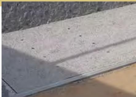
1882m<sup>2</sup> de revêtements semi-perméables et drainants des places de parkings, permettront de limiter l'imperméabilisation des sols.
