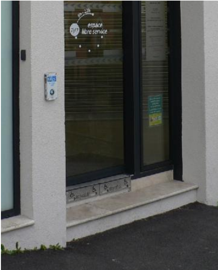
6. Exemple de mise en accessibilité d'un établissement privé (Crédit Agricole)
