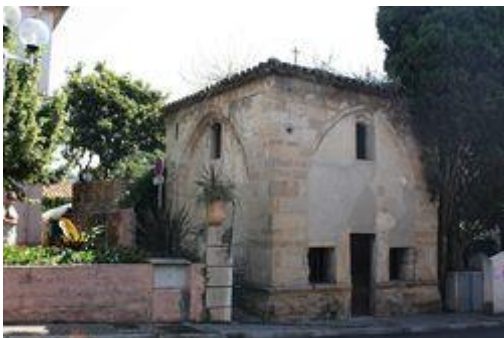
Figure 127 : Chapelle St Roch– source : DRAC PACA
