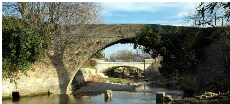
Figure 137 : Pont Vieux de Saint-Jean –source : Structurae
