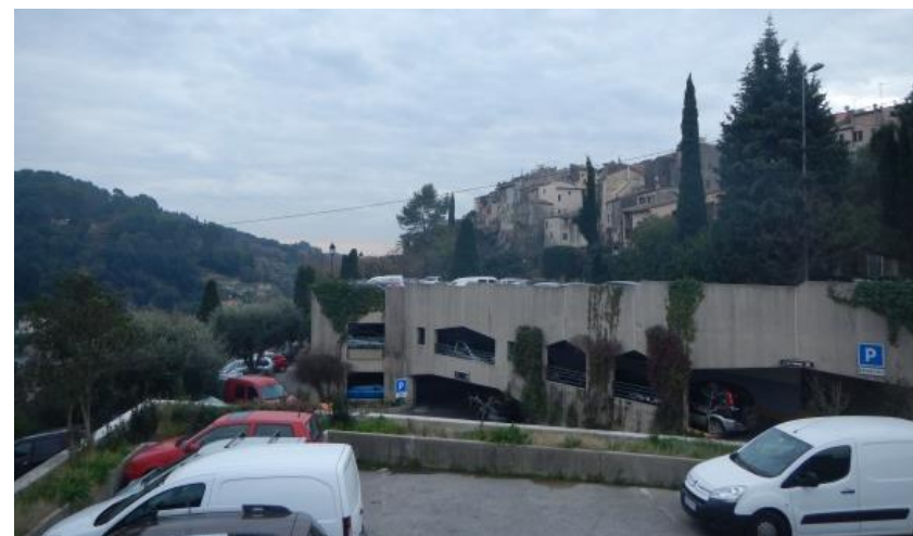
Photo 15 : Parking Saint-Jean (au-dessus) et parking des Bâchettes (en dessous) (Source : crédit CITADIA)
