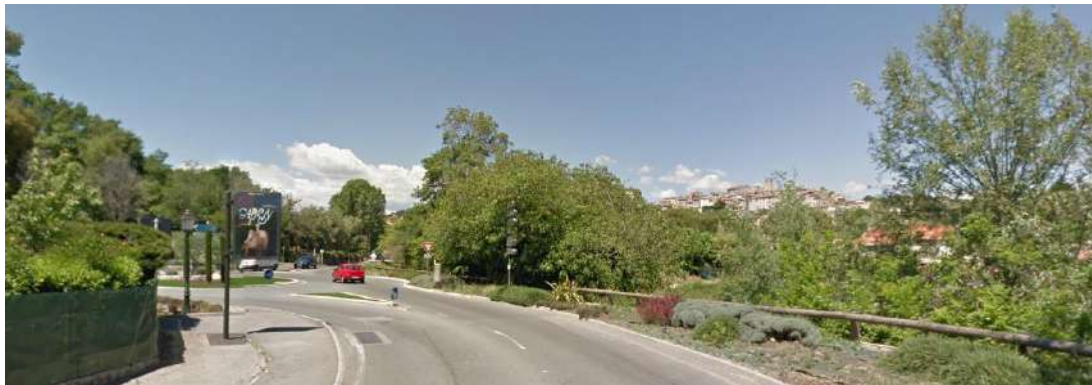
Sud du rondpoint Route d'Antibes
