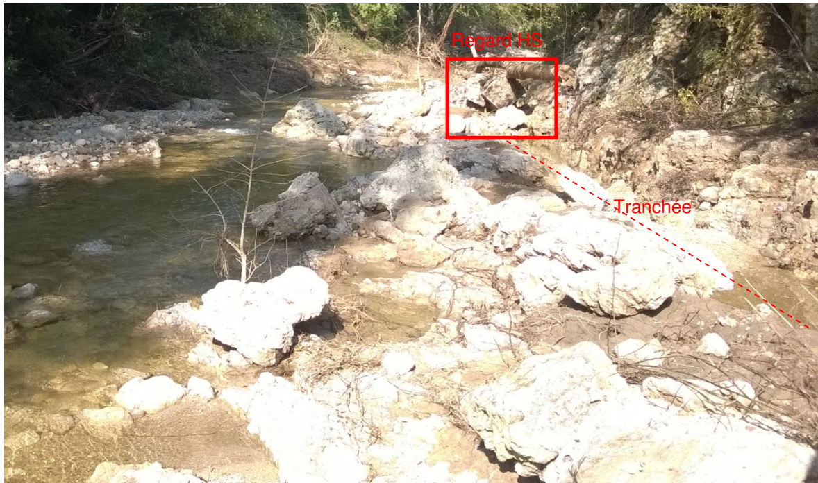
Figure 5 : Vers l'aval la conduite a disparue de la tranchée, le regard est détruit.
