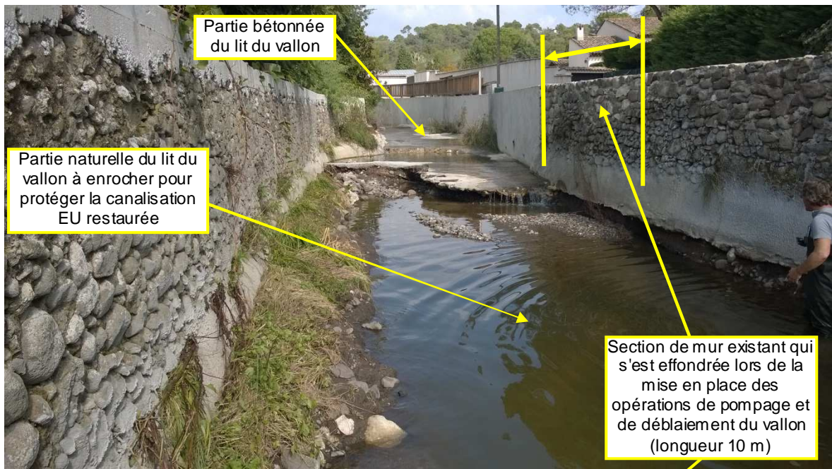
Figure 7 : l'incision est importante en aval du radier béton
