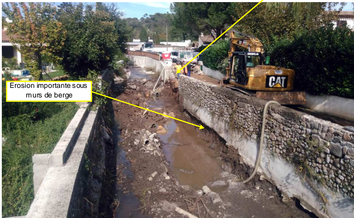
Figure 8 : opérations de pompage et de déblaiement du lit avec effondrement d'une section du mur de berge existant en rive gauche
