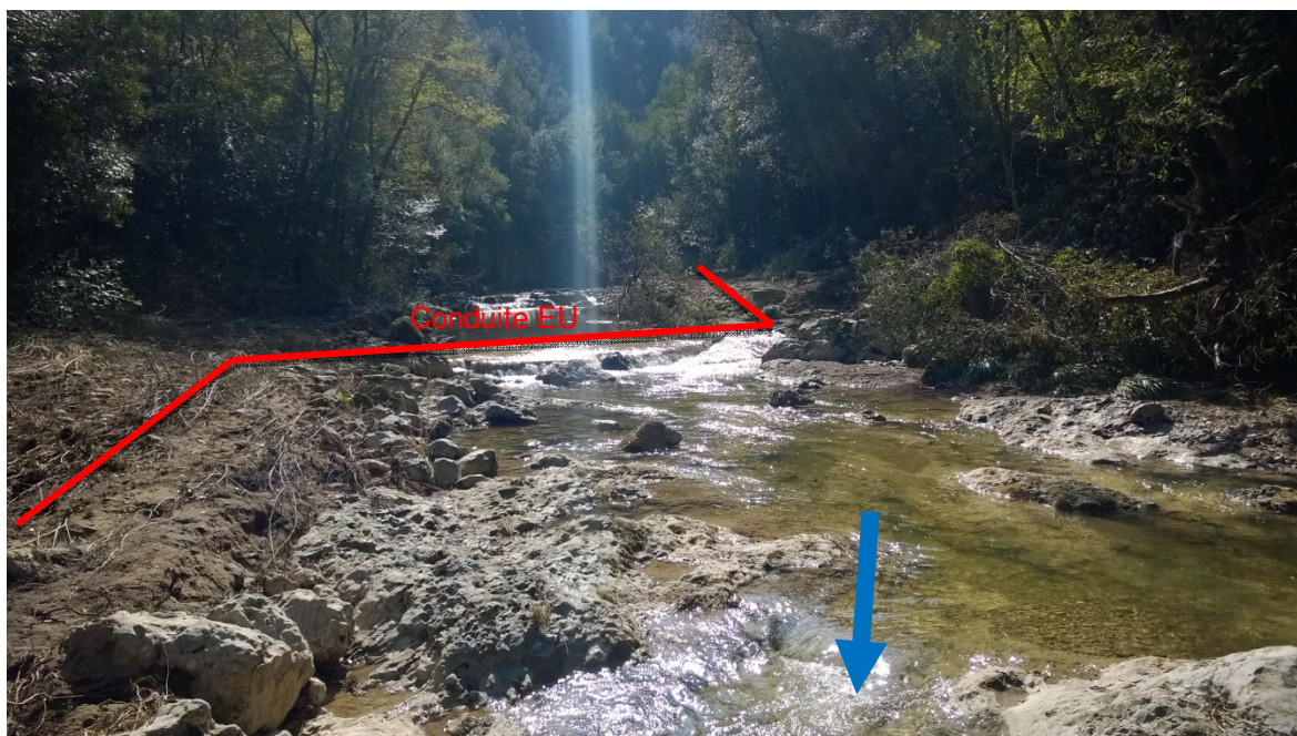
Figure 3 : En amont des dégâts, la conduite passe de rive gauche en rive droite sous un seuil.
