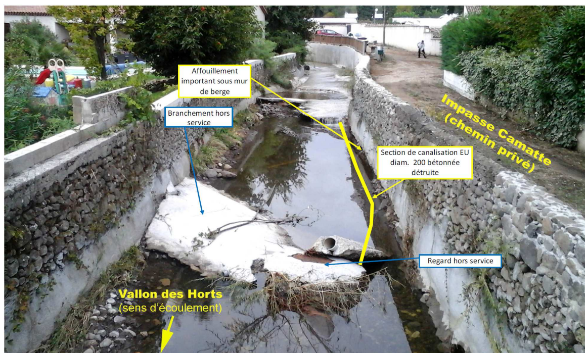
Figure 4 : La conduite et sa carapace béton sont complètement détruites
