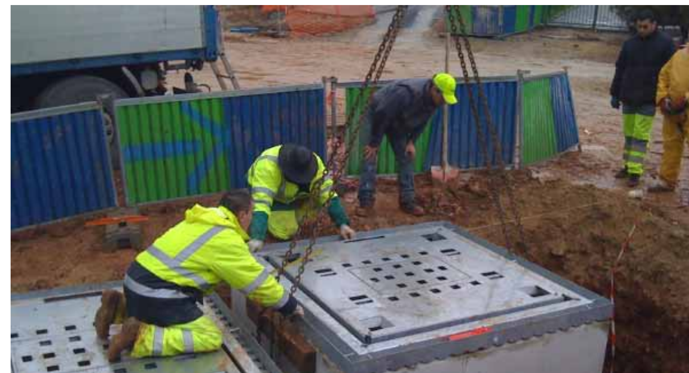
Bornes installées près de l'Orange Bleue à St-Philippe
