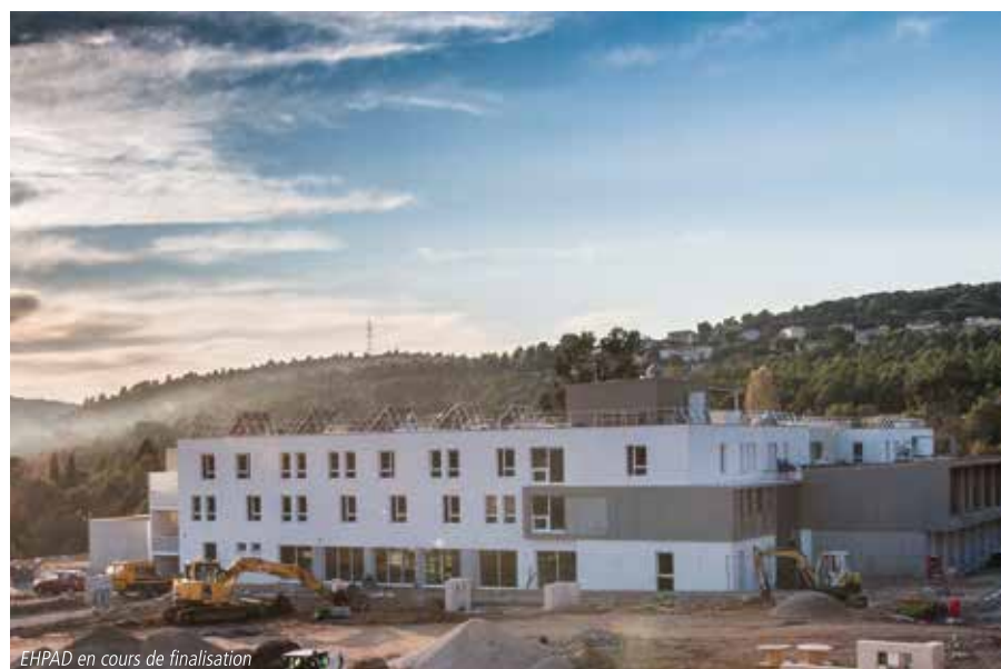
EHPAD en cours de finalisation
