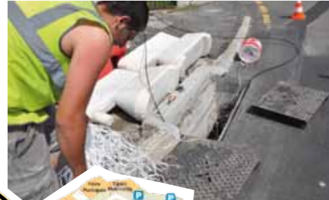
Pose des câbles de fibre optique
