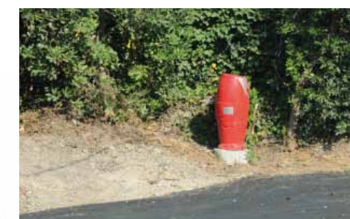
L'ensemble des poteaux d'incendie seront installés et mis en conformité d'ici septembre 2010
