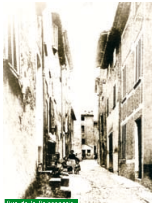
Rue de la Poissonnerie
