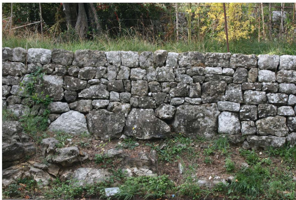
3- Mur de soutènement en pierre. Détail
