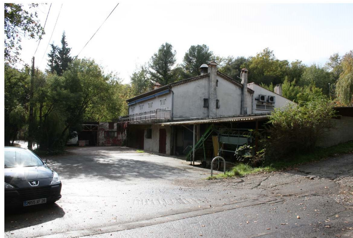
20- Cour de ferme ancienne
