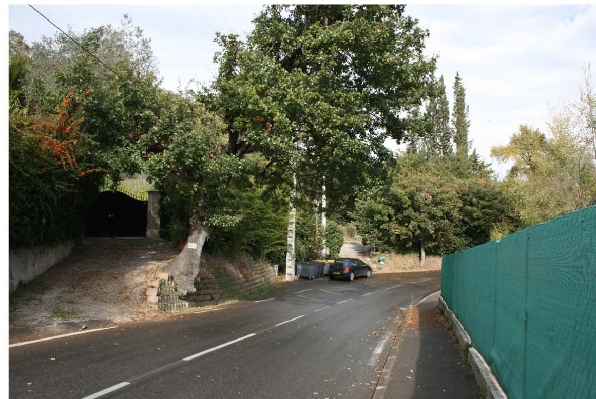
14- Entrée de propriété; mur en parpaings
