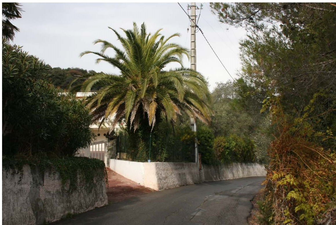
13- Entrée de propriété; mur enduit
