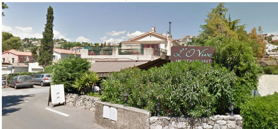
Enseigne en façade et chevalet, nombre d'activités limitée, ici Restaurant l'Olive
